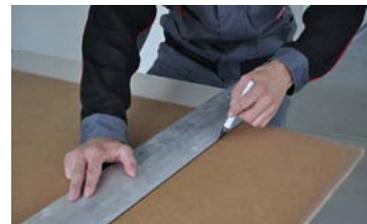
Резка звукоизоляционных панелей должна производиться в горизонтальной плоскости. Резать панели можно электро-лобзиком, отрезной машиной или ножовкой по дереву.
