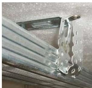
Обрешетка подвесной конструкции монтируется с шагом 400 на 800 мм. При монтаже такой обрешетки используется «одноуровневый соединитель краб»
